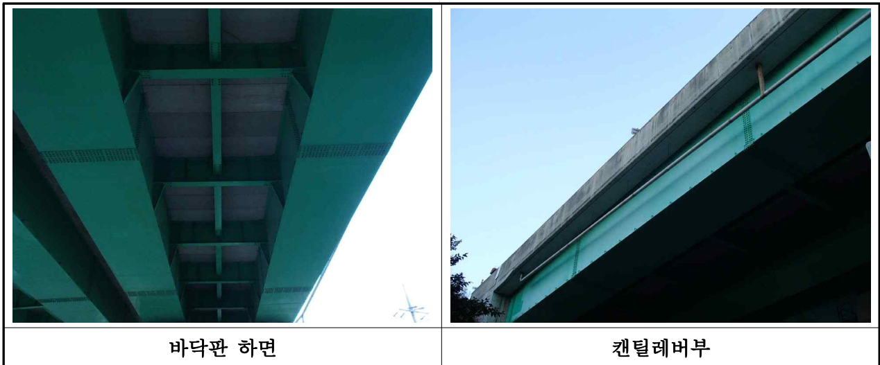
【사진 3.2.1】 바닥판 전경(대구)
