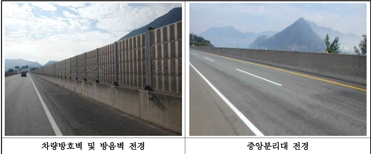
【사진 3.3.20】 방호벽 및 중앙분리대 전경(부산)
