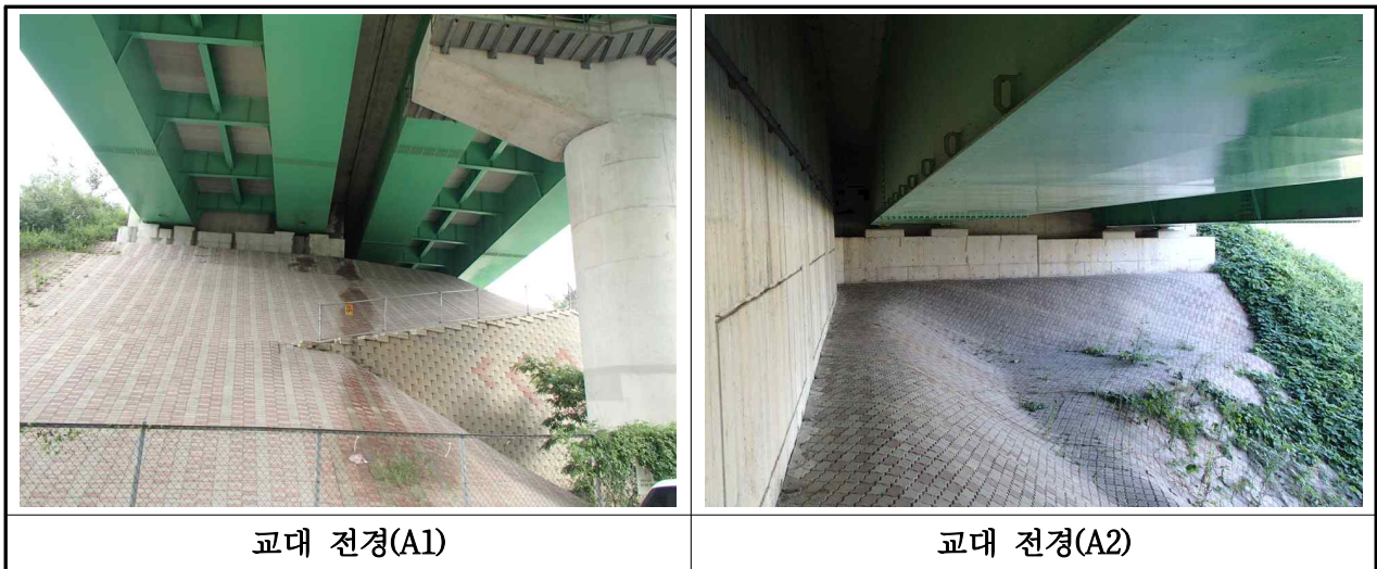
【사진 3.2.6】 교대 전경(대구)
