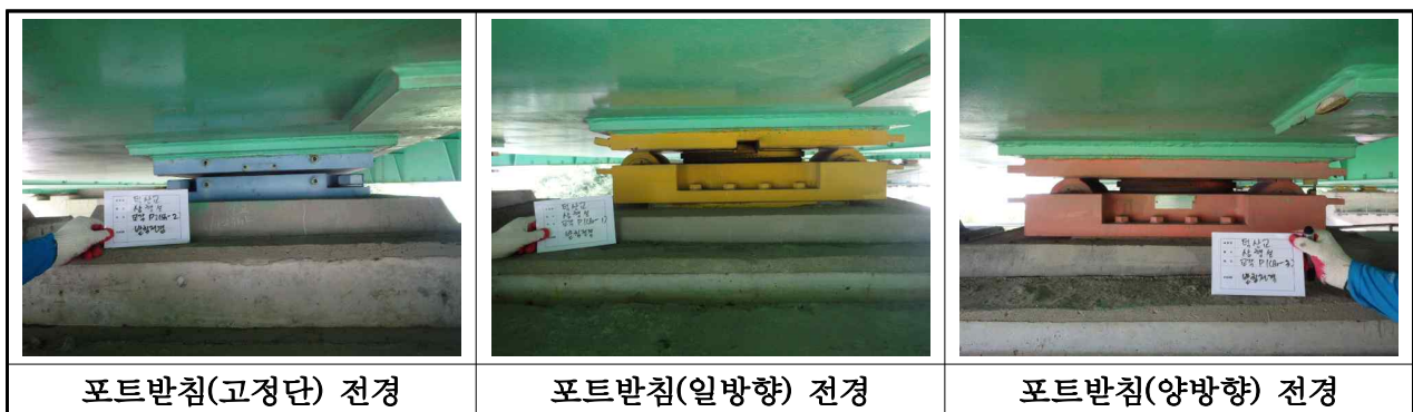
【사진 3.2.10】 교량받침 전경(대구)
