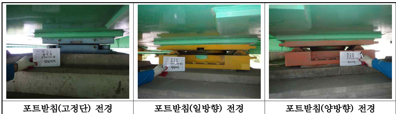
【사진 3.3.11】 교량받침 전경(부산)
