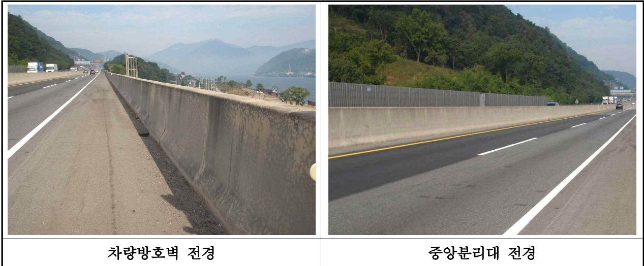
【사진 3.2.19】 방호벽 및 중앙분리대 전경(대구)
