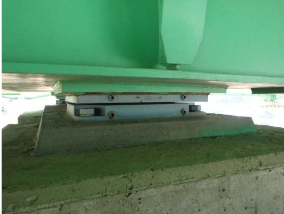
받침장치 전경 (고정단)
