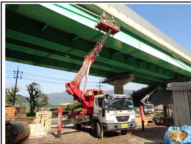
고소점검차를 이용한 조사(1)
