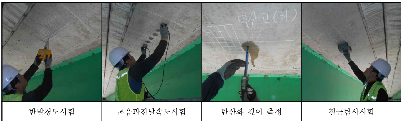
【사진 3.4.1】콘크리트 내구성조사 전경
