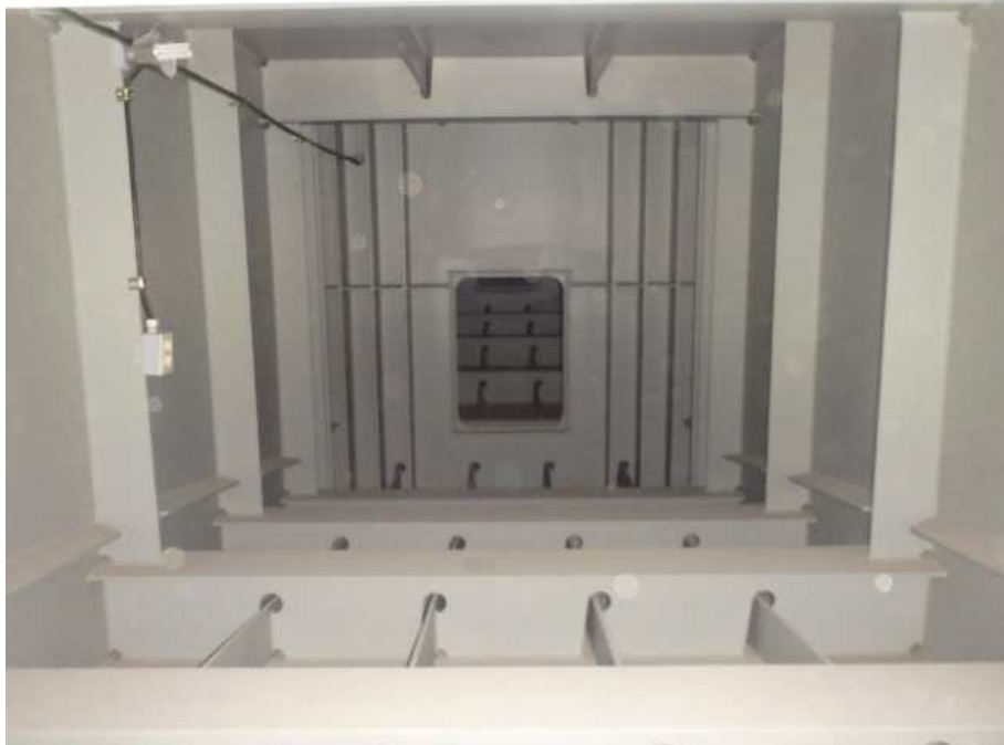
Steel Box Girder 내부 전경
