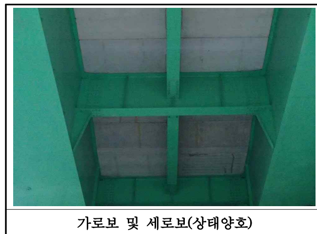
【사진 3.3.6】가로보 및 세로보 전경(부산)
