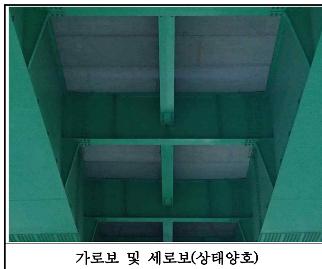
【사진 3.2.5】가로보 및 세로보 전경(대구)
