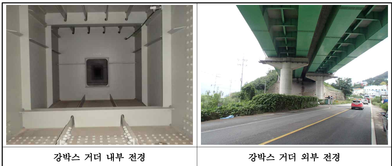
【사진 3.2.3】 강박스 거더 전경(대구)
