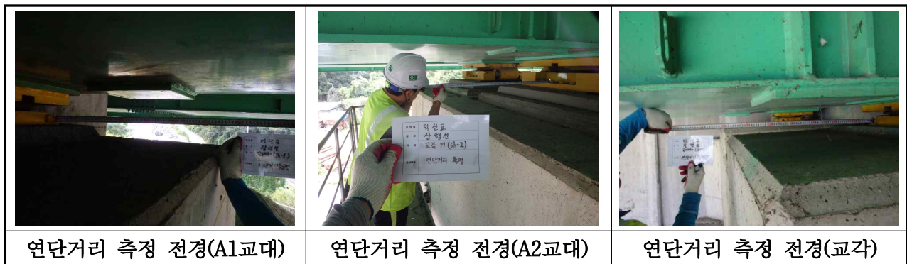
【사진 3.2.12】 연단거리 측정 전경(대구)
